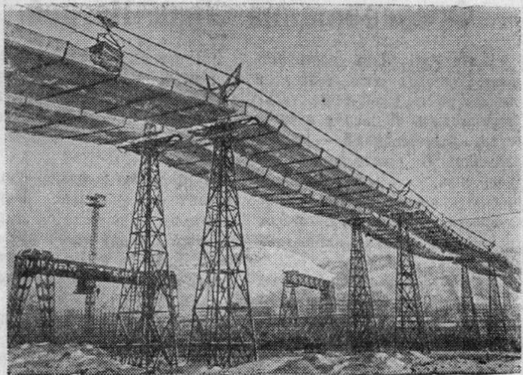
**Куйбышевгидрострой.** Вступил в строй участок канатной подвесной дороги от камнедробильного завода на горе Могутовой до бетонного завода. На этом участке по четырем стальным канатам движется более 70 вагонеток, которые перевозят 180 тонн щебня в час.
