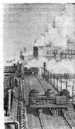
На Запорожском коксохимическом заводе все шире проводится механизация. Благодаря применению специального вагона на механизированной транспорте процесс загрузки коксовых печей углем.
