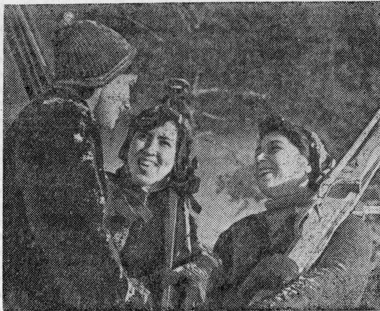
Они подруги. Кomsomolки Люба Власова, Надя Жаркова, Гали Ткаченко вместе работают штукатурами-малярами в отделе капитального строительства Кемеровского коксохимического завода.
