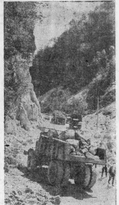
ГРУЗИНСКАЯ ССР. В горах Сванети сооружается оригинальная по техническому замыслу Ингурская ГЭС. Ее уникальная арочная плотина достигает высоты 300 метров, а деривационный канал протянется почти на 18 километров. Строителям предстоит проделать огромный объем работ. Только в тело плотины надо уложить 2 миллиона 800 тысяч кубометров бетона и железобетона.
