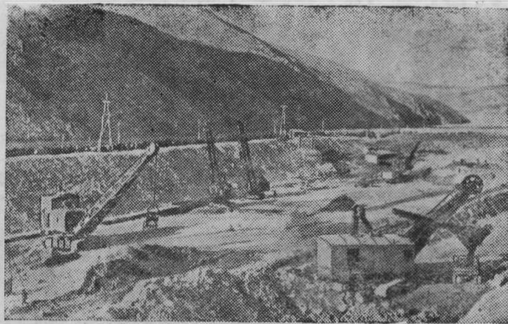
ВОСТОЧНО-КАЗАХСТАНСКАЯ ОБЛАСТЬ. Строители Бухтарминской ГЭС продолжают выемку грунта со дна Иртыша, орожденного перемычкой. Подготавливается место для укладки бетона в тело водосливной плотины.
