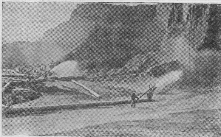
ЧЕЛЯБИНСКАЯ ОБЛАСТЬ. На Батурином угольном разрезе № 3—4 треста «Коркинуголь» наряду с экскаваторными работами широко применяется гидромеханизация на вскрыше и добыче угля. Этот метод комплексной механизации позволяет разрабатывать и транспортировать породу и уголь, обогащать его и убирать отходы в отвал. Гидромеханизаторы Батуриного разреза систематически перевыполняют план.
