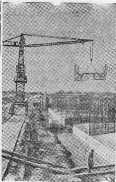
**ГРОЗНЕНСКАЯ ОБЛАСТЬ.** На реке Терек идет строительство Боргалинского гидроузла, при помощи которого будут орошены прилегающие земли. Река преграждается мощной плотиной. В котловане будущего русла Терека заканчивается сооружение последней секции водосброса и возводятся быки плотины.
