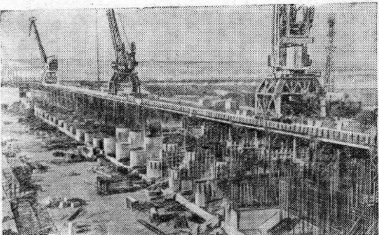
Строители Каховского гидроузла борются за досрочный пуск гидроэлектростанции в 1955 году. Полным ходом идет сооружение судоходного шлюза, водоотливной плотины и здания гидроэлектростанции. Уже установлены статоры четырех турбин. С опережением графика ведутся монтажные и бетонные работы.
