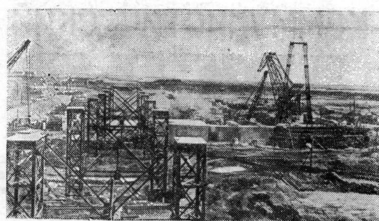
На строительстве Новосибирской гидроэлектростанции. В котловане под здание ГЭС в первой камере шлюза идет укладка бетона. Гидромеханизаторы ведут намыв пойменной части плотины. Мощные земснаряды уже намыли в тело плотины около трех миллионов кубометров грунта.
