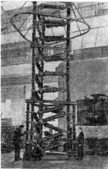
Ленинград. На заводе «Пролетарий» изготовлен разрядник коммутационного типа на 500 тысяч вольт. Обычные разрядники на такую мощность завод выпускал и раньше, но они предназначались только для предохранения линий от грозовых перенапряжений. Новый аппарат предохраняет их также от внутренних, так называемых коммутационных перенапряжений. Механизм состоит более чем из тысячи деталей. Высота аппарата 9 метров.
