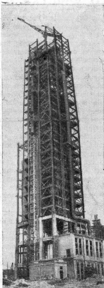
**Чечено-Ингушская АССР.** В Грозном сооружается опытно-промышленная установка контактного коксования. Все процессы нефтепереработки на ней будут автоматизированы и механизированы. Уже закончен монтаж металлических конструкций. Начата установка аппаратуры.
