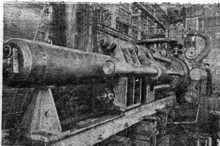
Московская область. На Коломенском заводе тяжелого стаканостроения закончена сборка и идет испытание нового уникального гидравлического трубопресса 667. Пресс такого типа выпускается заводом впервые. Вес его достигает 500 тонн. Он имеет электрогидравлическое управление.
