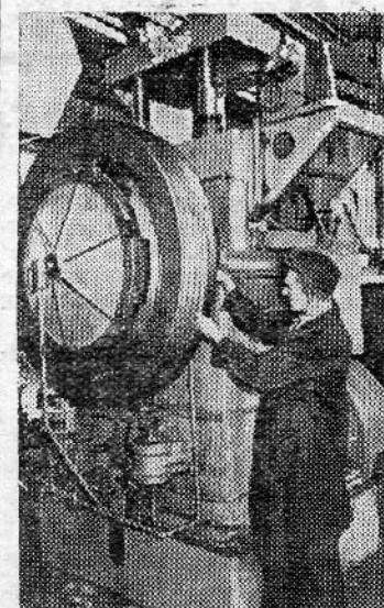
Рязанский завод тяжелого кузнецко-прессового оборудования выпустил новый листоштамповочный пресс-автомат усилием в сто тонн. Он предназначен для получения деталей из металлической ленты или полосы. На нем можно также производить вырубку, выгибку, вытяжку и другие операции. Управление прессом pneumatickое, кнопочное, смазка централизованная. Трехскоростной электродвигатель дает возможность автомату делать от 62 до 150 ходов в минуту.
