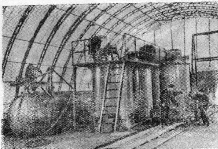
Московская область. Новый цех на Павшинском машиностроительном заводе называется несколько необычно — стационарный цех газобетонных изделий. Продукция его не механизмы, а строительный материал — газобетон.
