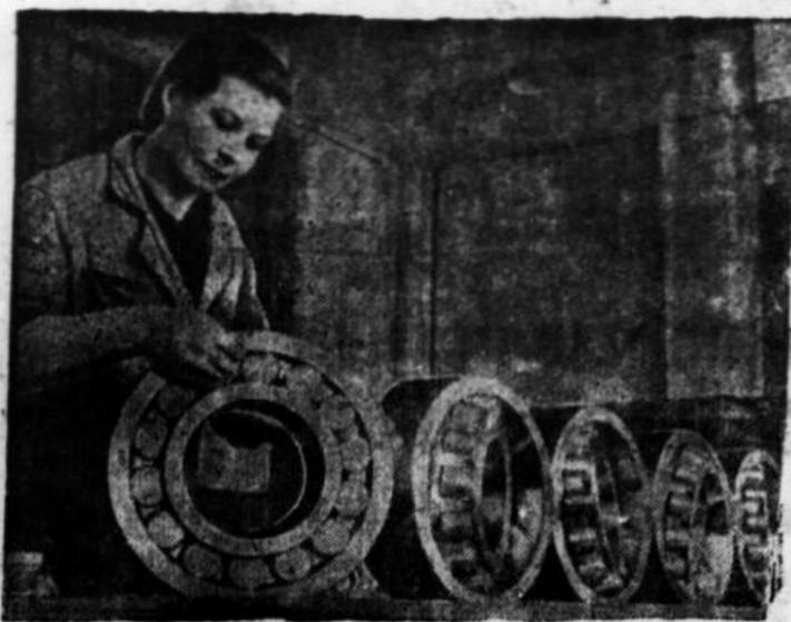
На подшипниковом заводе имени Л. М. Кагановича полностью освоено производство всех видов шарикоподшипников, ранее ввозившихся из-за границы. Своими изделиями завод снабжает автомобильную, тракторную, металлургическую, угольную, нефтяную и другие отрасли промышленности.
