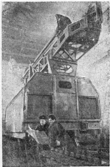
**ОРЕНБУРГСКАЯ ОБЛАСТЬ.** Продукция Бузулукского завода тяжелого машиностроения, в частности буровые станки для бурения вертикальных взрывных скважин на открытых горных работах, хорошо известна советским и зарубежным горнякам. В сборочном цехе завода заканчивается монтаж двух новых буровых станков «СВШ-200» (станок буровой шарошечный).
