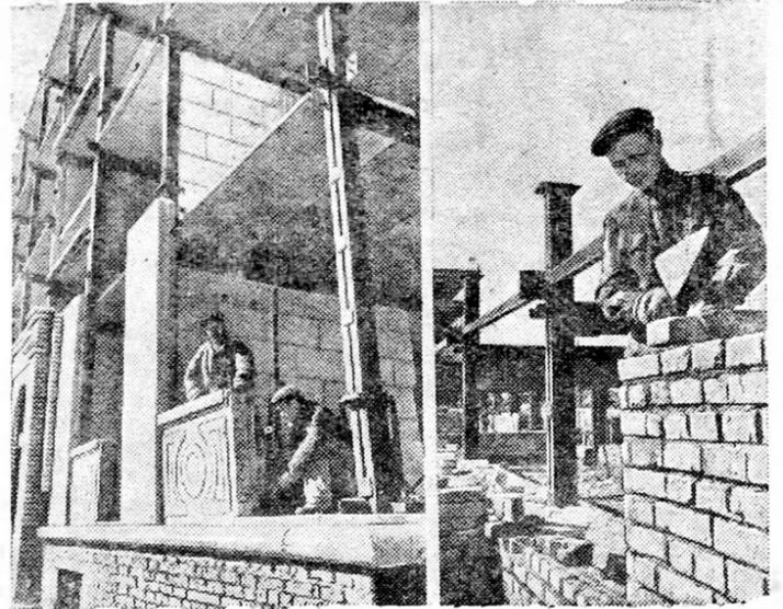
Москва. На Хорошевском шоссе развернулось скоростное строительство крупнопанельных жилых домов. Строительство ведется индустриальными методами — все детали изготавливаются на заводе, а на строительной площадке ведется только монтаж.
