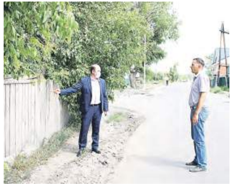
Дмитрий Фельдман и Олег Обухович проверяют ход выполнения ремонта дорог.
