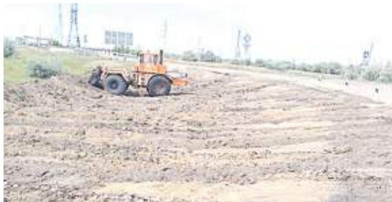
Идет снятие растительного грунта.
