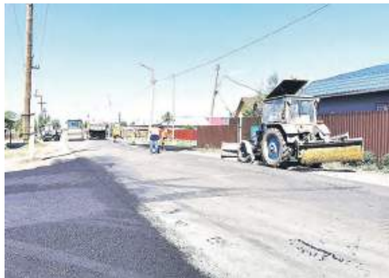
Выравнивающий слой асфальта на Станционном готов.
