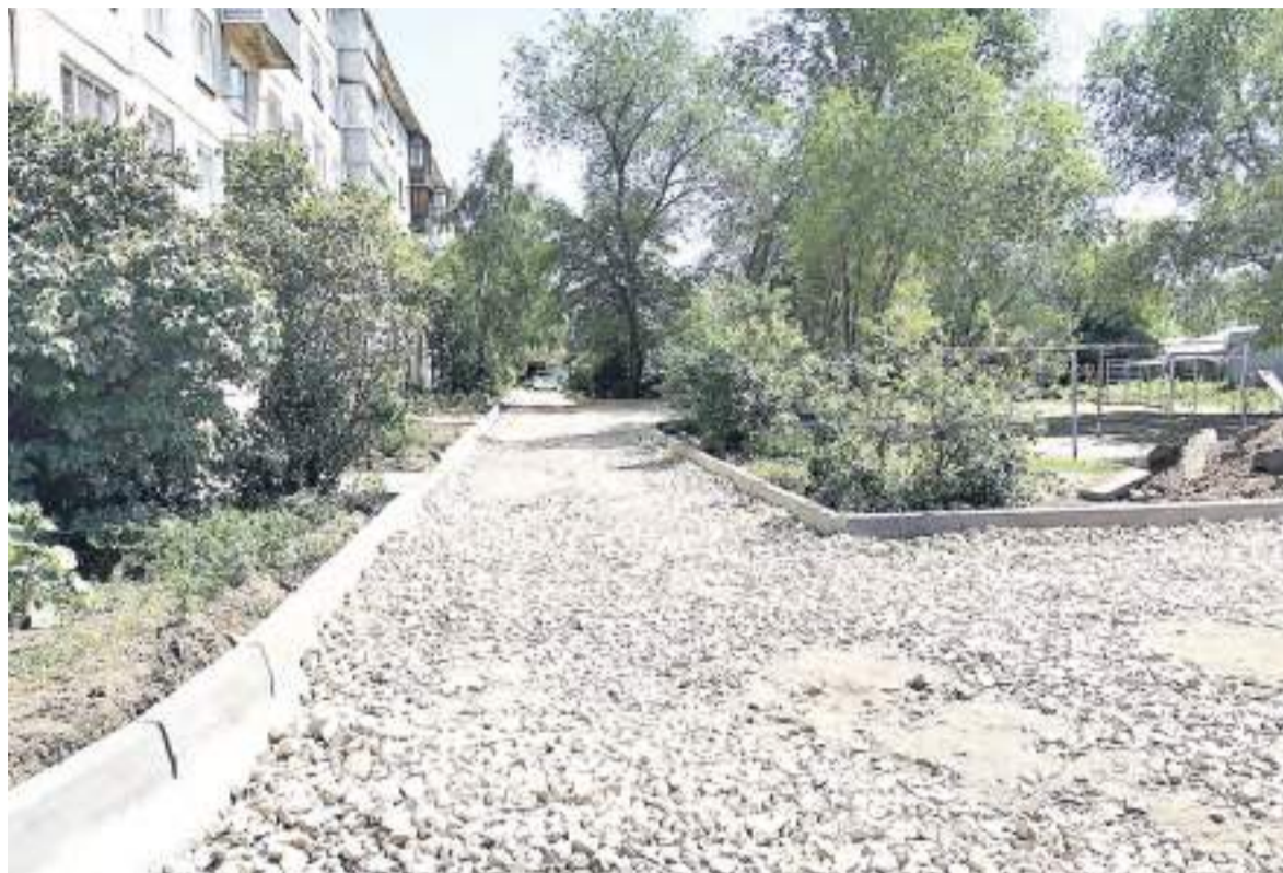
Обустройство двора по переулку Гражданскому, 33.
