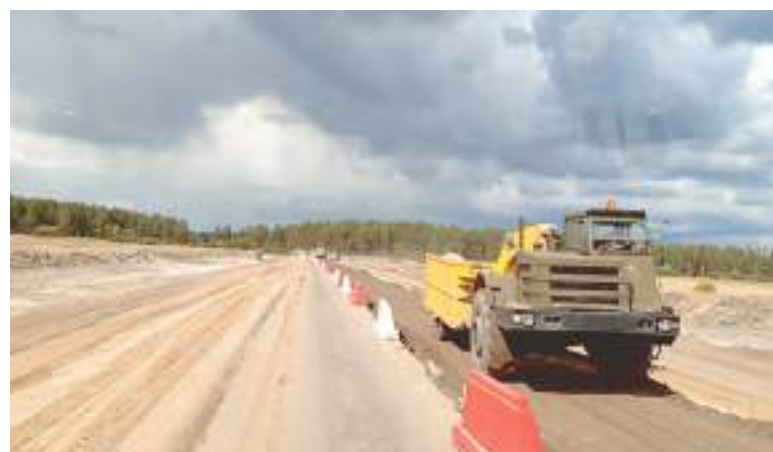
Строительство комплекса весового контроля.
