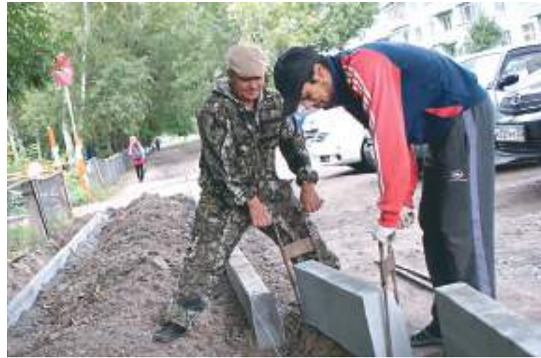
Новый тротуар обустраивают около гимназии № 8.
