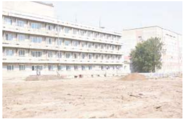
На территории горбольницы ведутся ремонтные работы.
