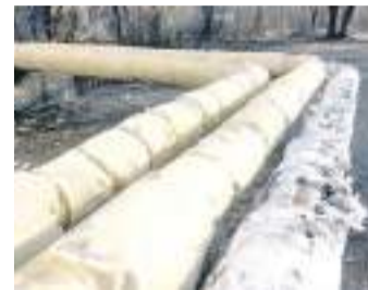
«Одень трубу». На наиболее изношенных участках труб восстановлена изоляция.
