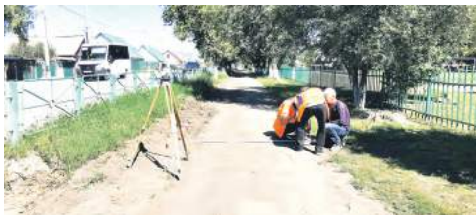
Обустройство тротуара у школы № 2.
