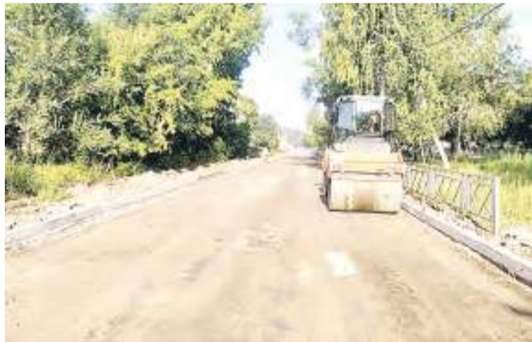
Идет укладка асфальта на южной стороне проспекта Рубцовского.
