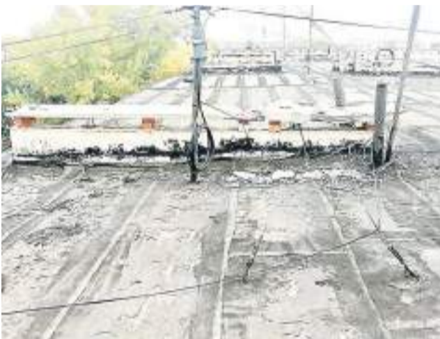
Г. Рубцовск, пр. Рубцовский, 33, крыша до ремонта.
