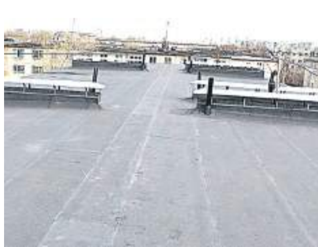
Г. Рубцовск, пр. Рубцовский, 33, крыша после ремонта.
