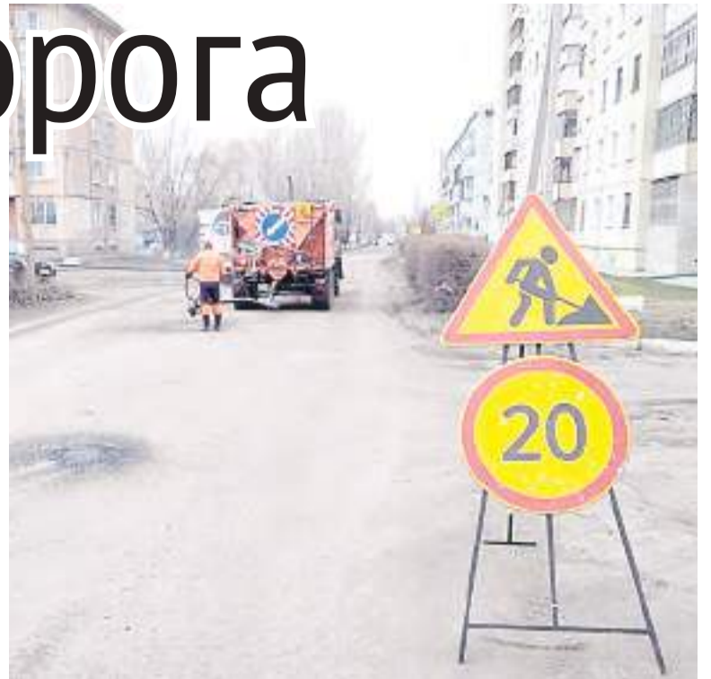
Ремонт переулка Гражданского.
