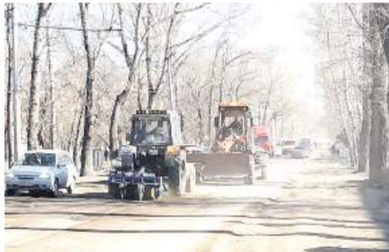
Юго-Западное ДСУ начало ремонт улицы Комсомольской.
