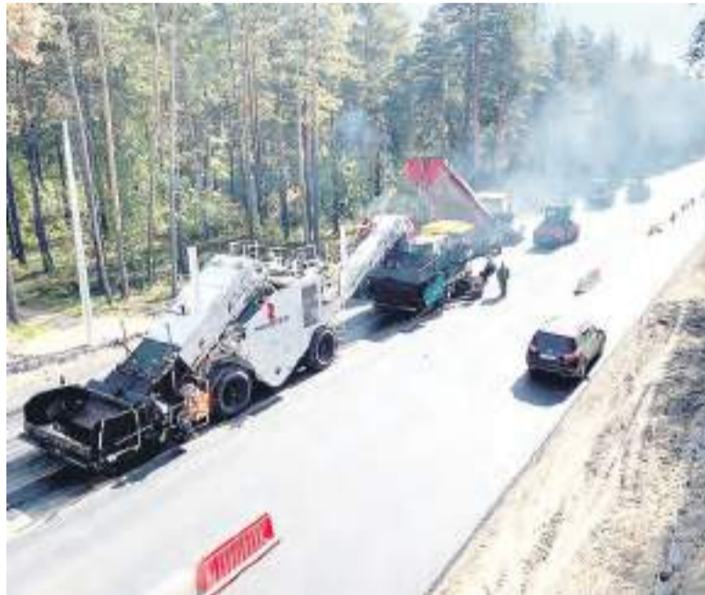
Работы на объездной дороге г. Барнаула.
