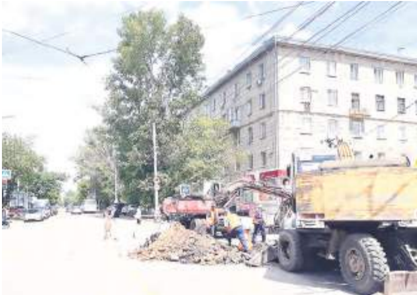
Ремонт ливневой канализации на пр. Ленина.
