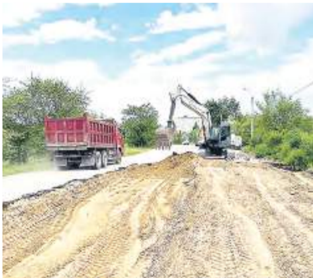
Начался ремонт ул. Транспортной.
