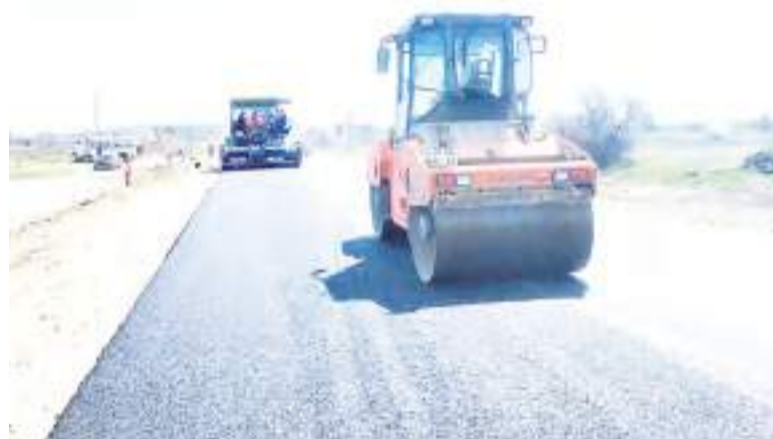
Ремонт ул. Тракторной.
