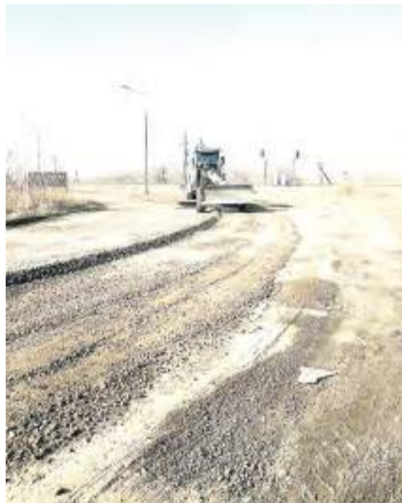
Идет грейдирование дороги.
