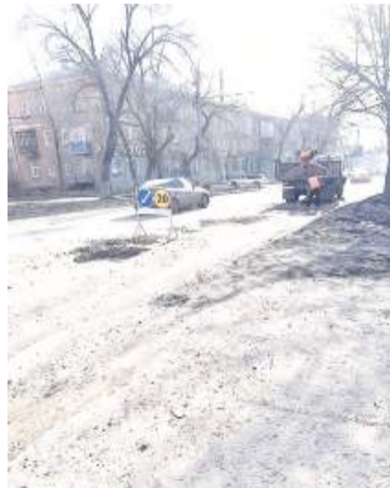
Подсыпка на ул. Октябрьской.
