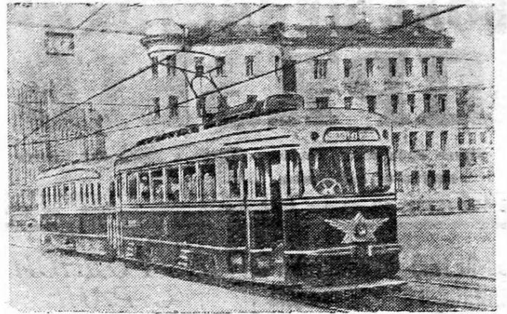
На улицах Москвы появился новый трамвайный поезд, построенный на Усть-Катавском заводе. Он состоит из двух темпосиных вагонов обтекаемой формы. Моторный вагон имеет высокооборотный двигатель. Прицеп оборудован автоматически действующим тормозом. Новыми вагонами будут пополняться трамвайные парки городов Советского Союза.
