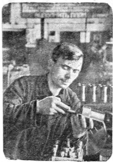
ЛЕНИНГРАД. Токарь завода «Русский дизель» В. И. Марков, применяя метод Борткевича и используя приспособления собственной конструкции, добился исключительно высокой производительности труда на токарном станке при максимальных скоростях. На днях тов. Марков выполнил 20 норм в смену. Он обрабатывал каждую деталь за 4 минуты вместо положенных по норме 1 часа 40 минут. На снимке: токарь скоростник В. И. Марков за работой. Фото И. Фетисова
