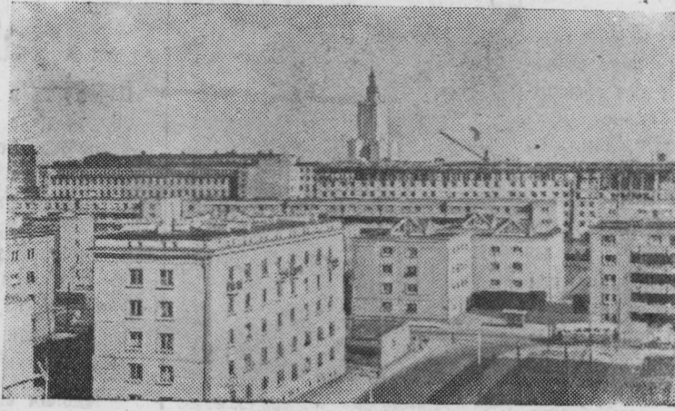
ПОЛЬСКАЯ НАРОДНАЯ РЕСПУБЛИКА. В Варшаве идет большое жилищное строительство. Вырастают благоустроенные жилые дома, здания культурных и бытовых учреждений. Ежегодно варшавяне получают тысячи квартир в новых домах. На снимке: новые жилые дома в районе Муранов. Вдали—Дворец культуры и науки имени И. В. Сталина. Фото Польского Центрального фотоагентства.
