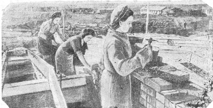
Развернулись работы по восстановлению Пулковской обсерватории под Ленинградом. На снимке: кладка стен одного из зданий обсерватории.
