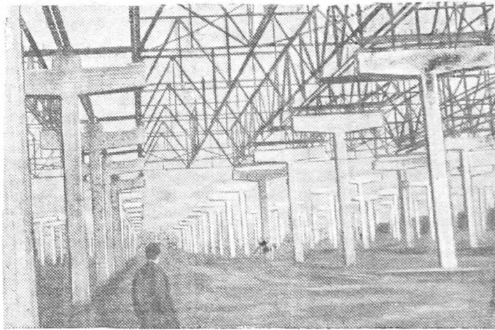
Строительство конвейерного цеха Кутаисского автомобильного завода. Фото П. Луценко. Прессклише ТАСС
