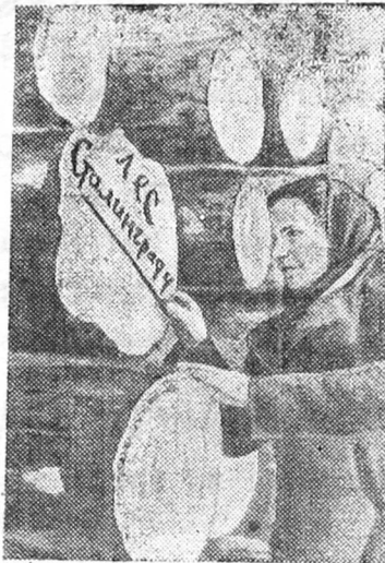
Семёновский лесопункт Горьковской области получил почётный заказ—заготовить 1.000 кубометров строительного леса для Сталинграда. Этот заказ был выполнен досрочно.
