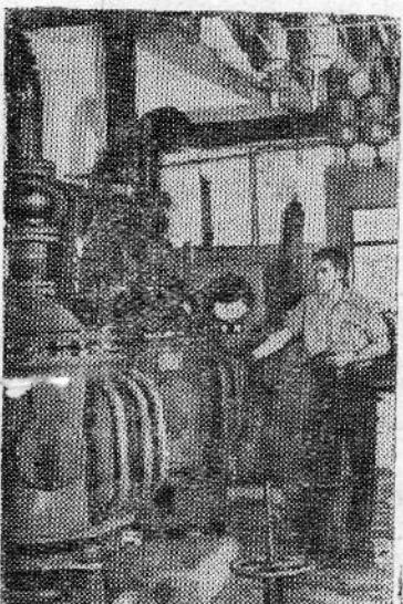
Башкирская АССР. Рационализаторы промысла № 4 «Туймазанефти» внедрили в производстве новый способ обработки нефти при помощи высокочастотной электрообессылающей установки. Это дает большой экономический эффект. Себестоимость обработки одной тонны нефти значительно снизилась.
