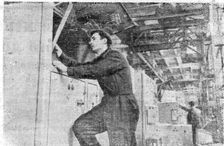
На Московском трансформаторном заводе имени Куйбышева заканчиваются работы по монтажу первых пяти электрических распределительных устройств, предназначенных для отправки в адрес строящегося в Бхилае (Индия) металлургического завода.
