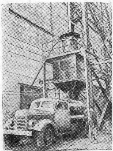
Ярославль. На теплоэлектростанции Ярэнерго сооружена первая промышленная установка по производству торфозольного цемента.
