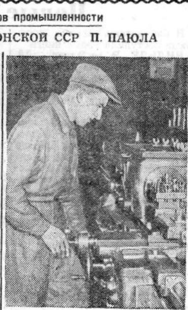
Сократить время при обработке цилиндрических поверхностей, токарь успешно применил индикатор, который дает возможность легко измерять детали с точностью до 0,01 миллиметра. Это приспособление сейчас широко используется на заводе.
