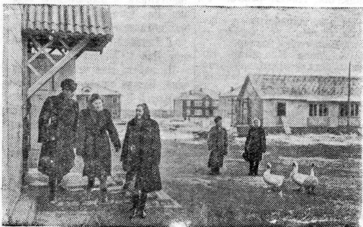
САРАТОВСКАЯ ОБЛАСТЬ. В новом совхозе «Дергачевский», основанном на целинных землях, сооружено около тридцати жилых домов, столовая, баня и другие помещения. На снимке: центральная усадьба совхоза «Дергачевский».
