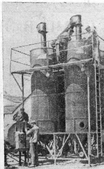
**ЧЕХОСЛОВАЦКАЯ РЕСПУБЛИКА.** Коллектив научно-исследовательского института пищевой промышленности предложил новую конструкцию зерносушки. Новый механизм испытывается в полевом стане села Грабетице в Моравии. Для подогрева воздуха зерносушки используется переоборудованный старый локомобиль, который нагревает в час 40 тысяч кубометров воздуха до 130 градусов. Остальные узлы зерносушки приводятся в действие дизельным мотором. Производительность агрегата 10 вагонов зерна в сутки.
