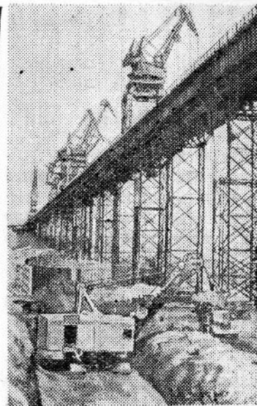
СТАЛИНГРАДГИДРОСТРОЙ. Подготовна площадки для монтажа арматуры.
