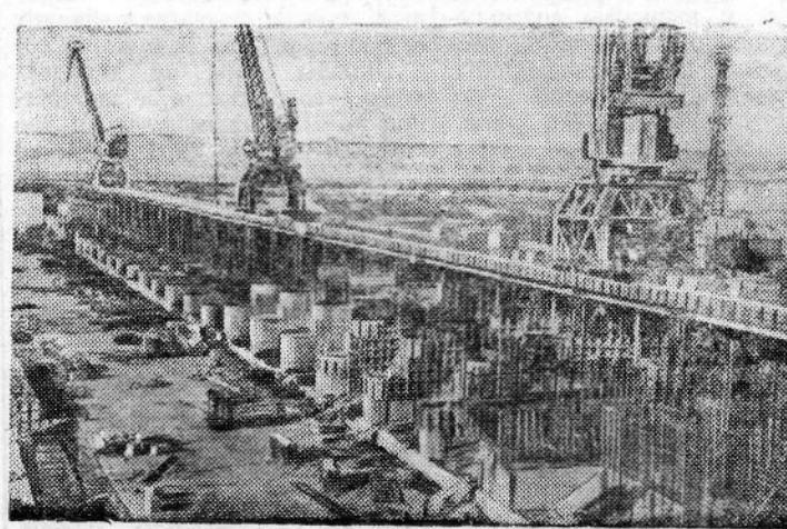
Строители Каховского гидроузла борются за досрочный пуск гидроэлектростанции в 1955 году. Полным ходом идет сооружение судоходного шлюза, водосливной плотины и здания гидроэлектростанции. Уже установлены статоры четырех турбин. С опережением графика ведутся монтажные и бетонные работы.
