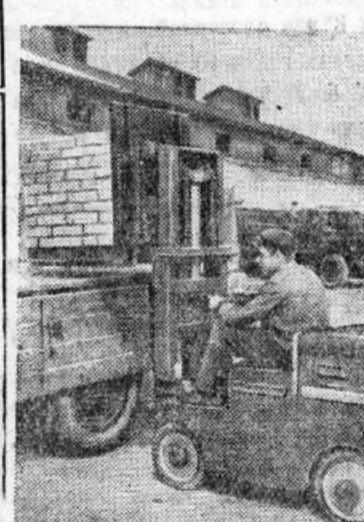
Московский завод № 1 «Росмашстрой» Министерства промышленности стройматериалов РСФСР изготовил и передал для эксплуатации Нижне-Котельскому кирпичному заводу два новых электропогрузчика «ЭПК-1000». Электропогрузчик представляет собой тележку с электрическими аккумуляторами. Специальным приспособлением он захватывает штабель из двух кирпичей, транспортирует его и грузит на автомашину.
