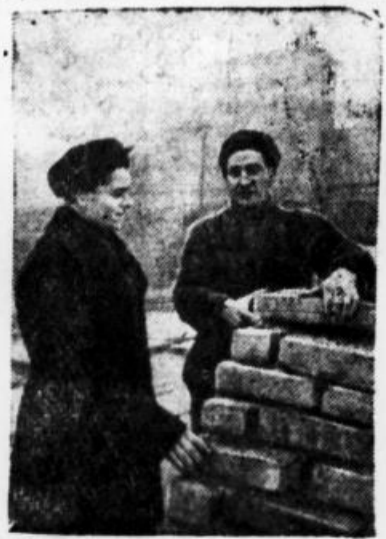
Группа комсомольцев Советского района Москвы выехала железной дорогой на строительство новых жилых домов. На снимке: знаменитый каменщик, депутат Верховного Совета РСФСР тов. Шевякин беседует с рабочим завода «Гостехсвет» Евгением Илюхиным, который подал заявление о переходе на строительство жилищ. Фото Н. Кареева и Н. Маньча. Пресс-клуб ТАСС.
