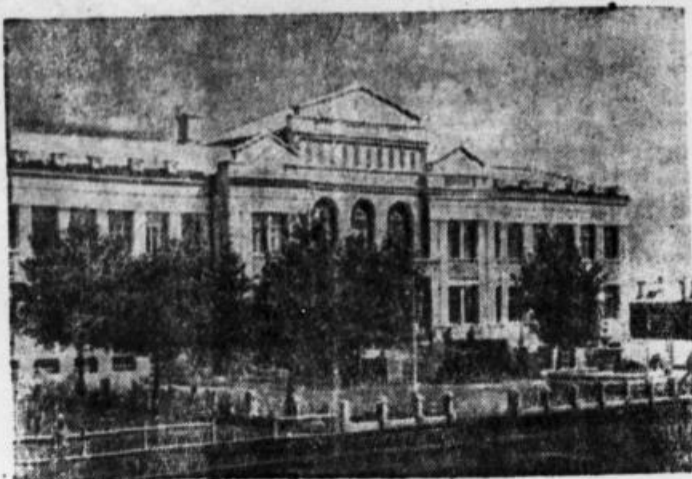
Восстановленное здание Управления крупнейшего в Донбассе треста «Боквоантрацит».
