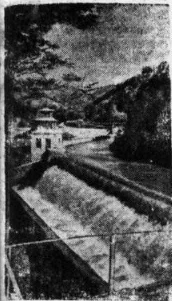
В Армянской ССР орошаются около 200 т. га земли. Длина оросительной системы превышает 10000 километров. Одним из самых крупных сооружений республики является канал имени Сталина. Его протяженность 64 километра. На снимке: боковой водослив на канале имени Сталина.
