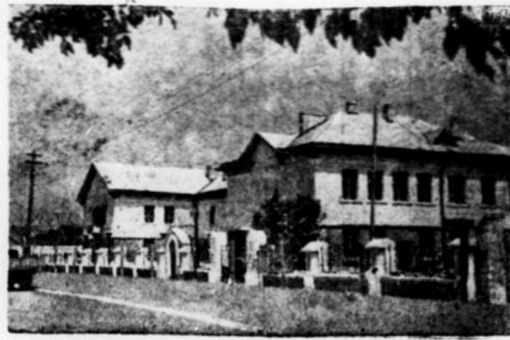
Молдавская ССР. В Кишиневе закончено строительство нового здания средней школы для детей железнодорожников.
